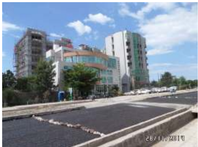
Awassa: aanleg nieuw hotel met asfaltweg
